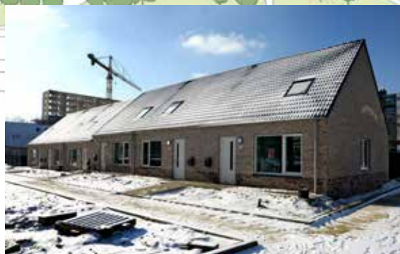
Begin 2020 zijn de vijftien circulaire woningen op het vacuümrivol aangesloten.
