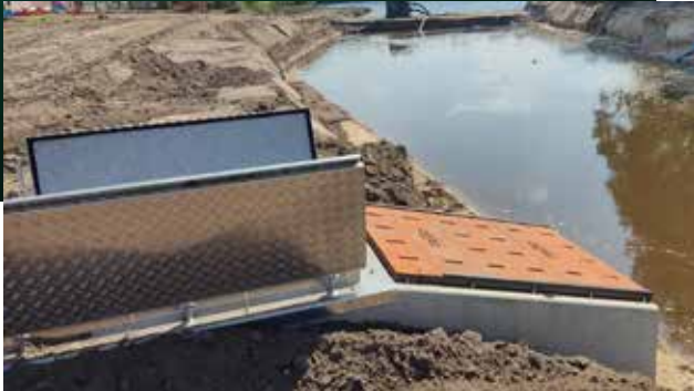
Net geplaatste prefab inlaatconstructie in (toekomstig) grastalud.
