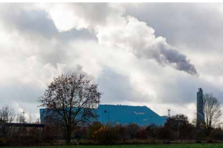
De warmtenetten van Enschede en Hengelo worden gevoed vanuit de biomassacentrale AVI Twence.
