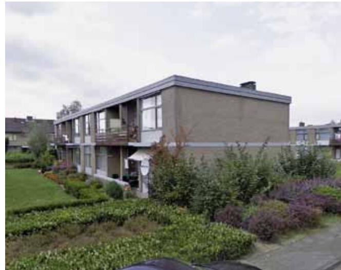
Woningen Nieuwkuijk, links oude voorgevel, rechts nieuwe voorgevel
