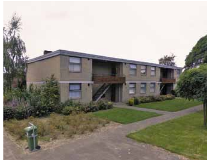
Woningen Nieuwkuijk, links oude achtergevel, rechts nieuwe achtergevel
