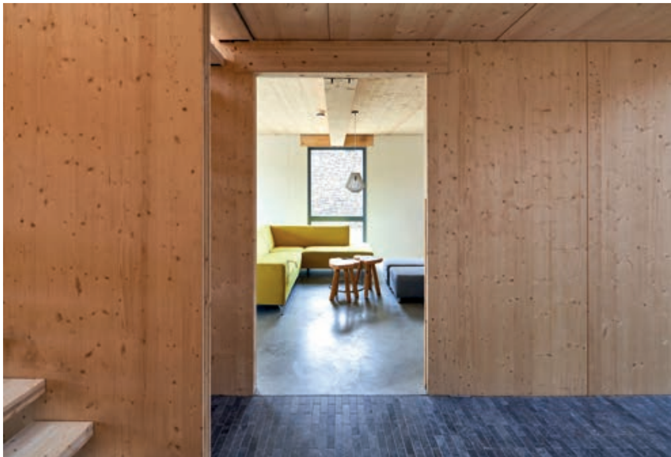
Dit woonhuis in Berkel-Enschot is volledig opgetrokken in CLT ( cross laminated timber , kruislings verlijmd hout). Dat bleek goedkoper en sneller.
